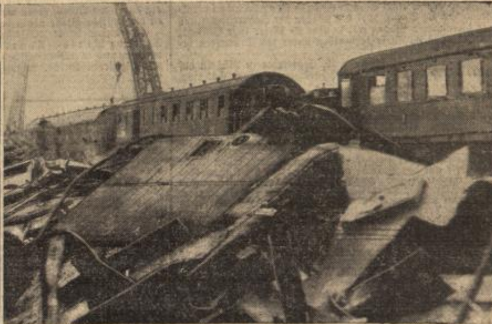
Das Trümmerfeld der umgestürzten und ineinandergeschachtelten Wagen.
