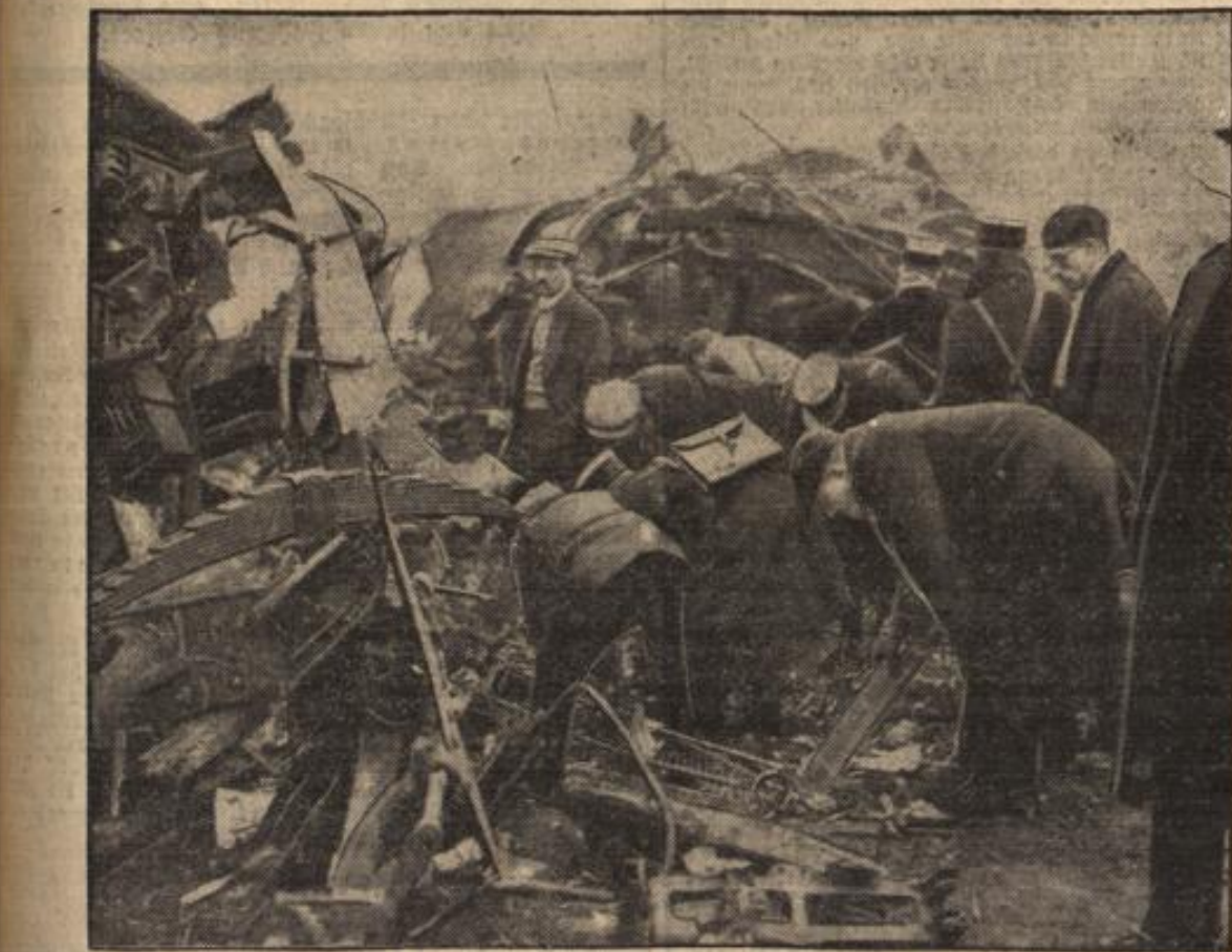
Aufräumarbeiten an der Trümmerstätte.
