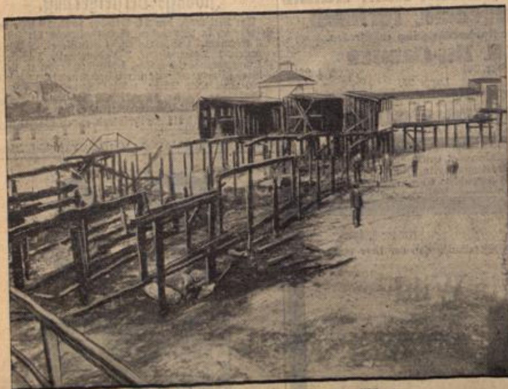
Das Familienbad von Swinemünde eingestürzt. Die verkohlten Holzbauten nach dem Brande.
