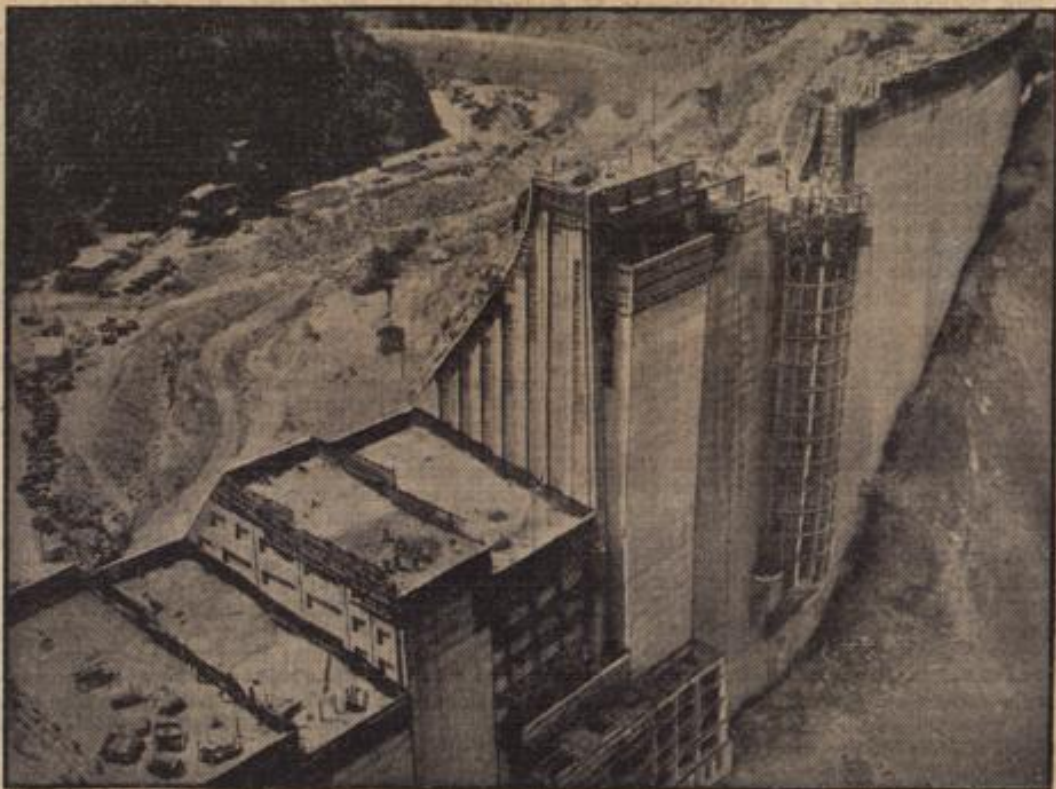
Vor der Vollendung eines Niesen-Staudamms in Kalifornien.
