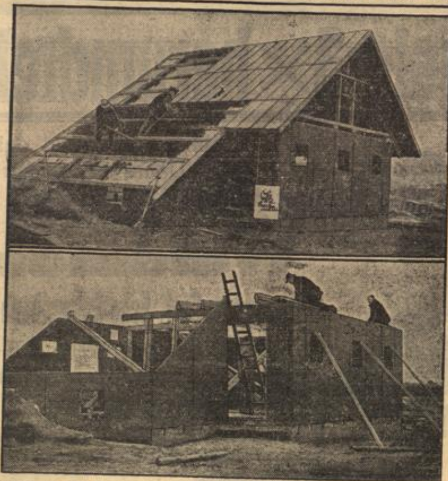
Stahlhäuser für Erwerbslosen-Siedlungen können in 10 Tagen errichtet werden.
