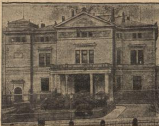
Die Henschel'sche Privatvilla in Kassel soll abgerissen werden.
