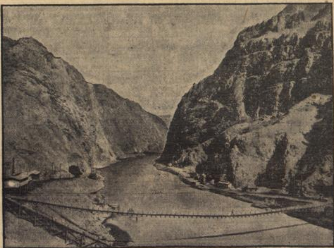
Amerika baut einen Riesenstaubdam für die Bewässerung der mittleren Südstaaten.
