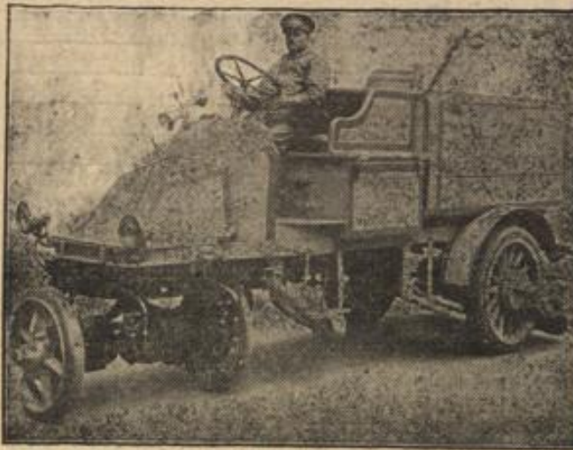
Das elektrische Pferd als Vorspann vor einer Straßenwasmaschine.
