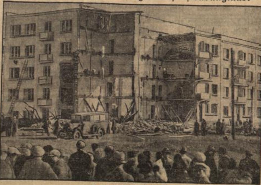
Der zerstörte Neubaublock
