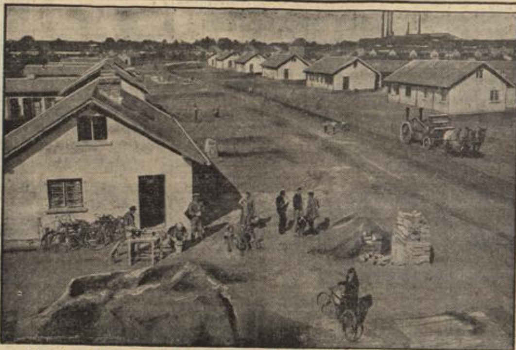
Ein Weg zur Vinderung der Arbeitslosennot: Bau von Arbeitslosenwohnungen.
