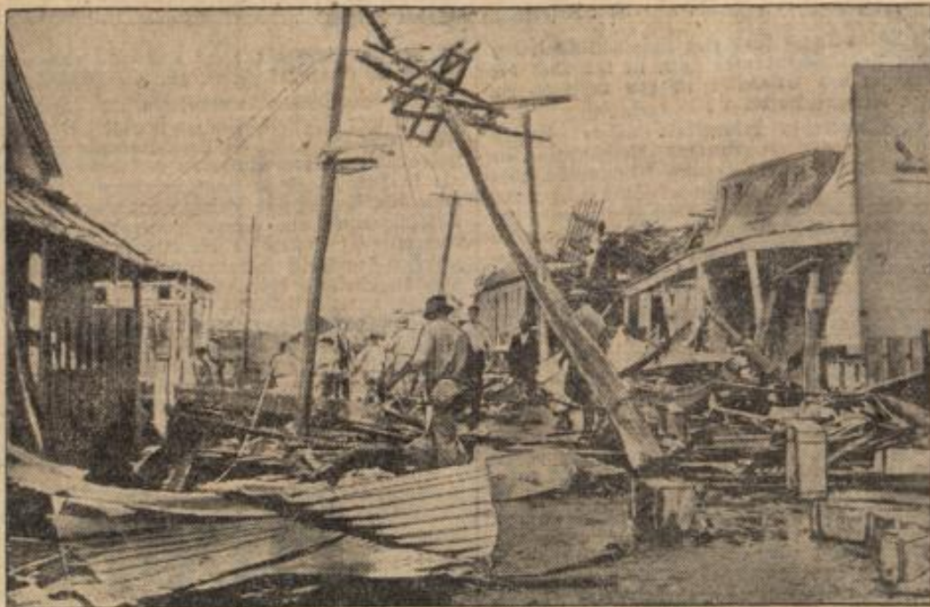
Erste Originalaufnahme von den furchtbaren Wirbelsturmverwüstungen auf Honduras. Trümmer eingestürzter Häuser in Belize (Britisch-Honduras).
