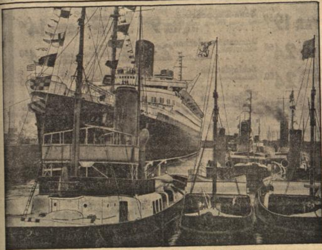
Die Nordshleuse von Bremerhaven in Betrieb genommen.
