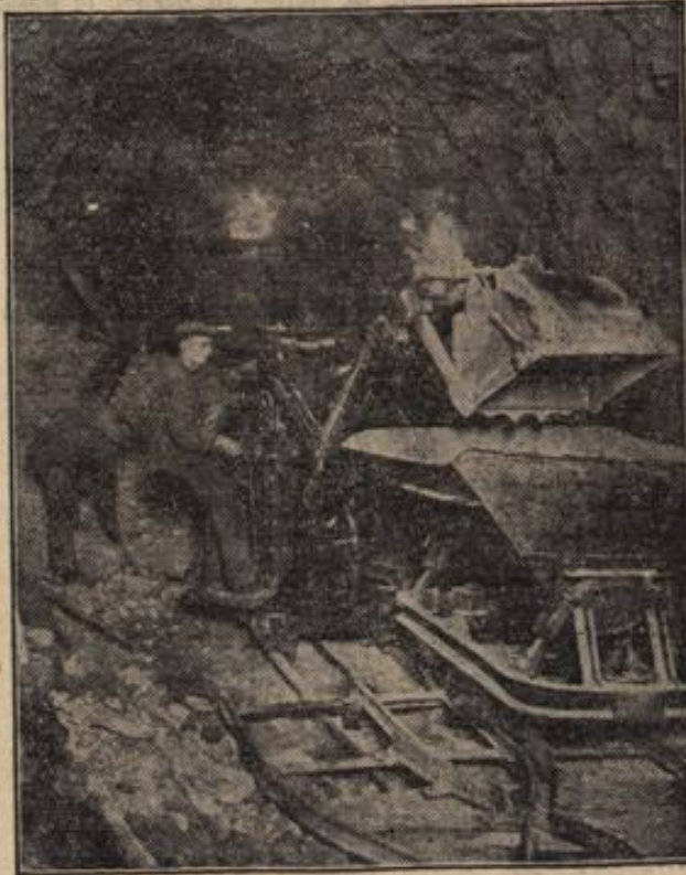
Der neue Schaufellader beim Bau des Eichholz-Stollens des Schlufsee-Kraftwerkes. (Phot. Demag)
