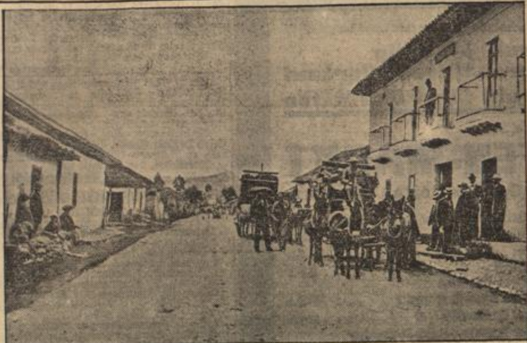
Schwere Erdbebenkatastrophe in Ecuador. Die Hauptstraße von Latacunga (Ecuador), die völlig zerstört wurde.
