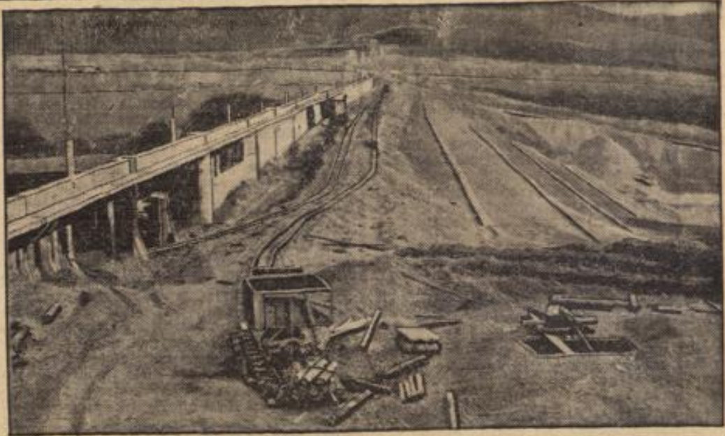
Die Söfetalperre bei Osterode i. H. vor der Fertigstellung.
