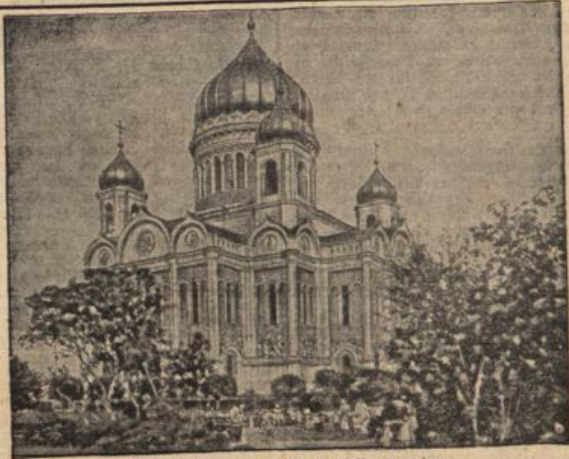
Dieses Gotteshaus soll abgerissen werden.
