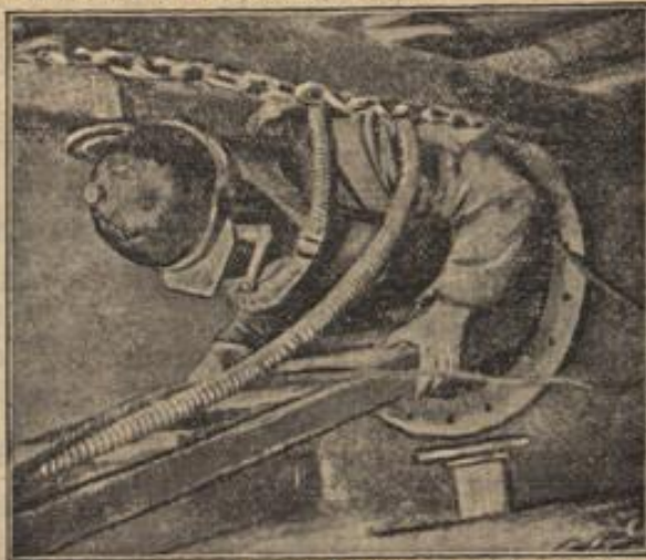
Durch ein engeres Mauerloch bestiegt der Untersucher, mit Gashelm und Atmungsgerät ausgerüstet, einen unterirdischen Betriebsstofftank.
