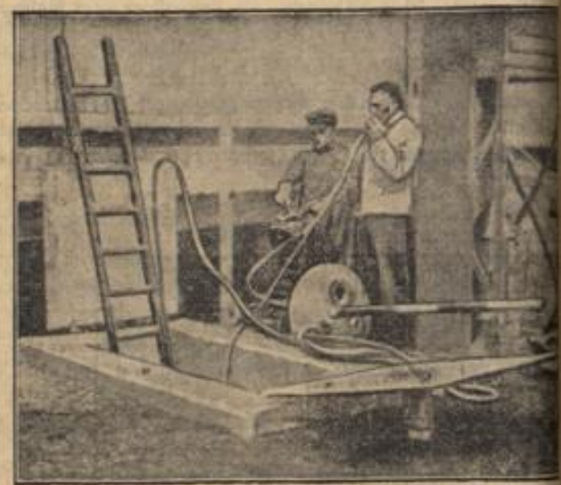
Der geöffnete Schacht einer unterirdischen Tankanlage während der Unterhaltungsarbeit. Der Mann links bedient die Luftpumpe für das Atmungsgerät, während der rechte Mann den telefonischen Befund über das Reifestellnetz entgegennimmt.
