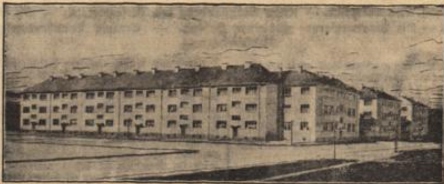
Die Häuserfront der „Mibau“ (114 Kleinwohnungen) zwischen Karl-, Pfälzer, Lombacher und Andreasstraße in Wiesbaden-Biebrich.
