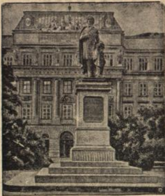
Von einem Brande heimgesucht.
