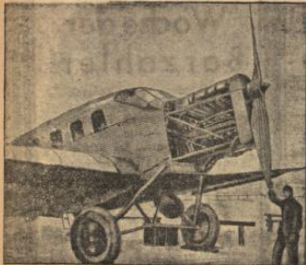
Unser Bild zeigt einen Schwerdmotor, der in eine Junkers-Maschine vom Typ G 24 eingebaut wurde.
