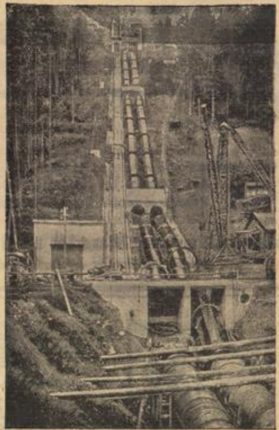
Neues deutsches Großkraftwerk im Bau.
