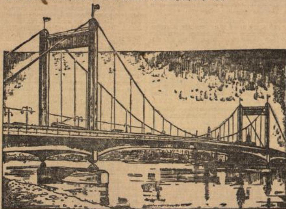
(Die neue Rheinbrücke bei Köln-Mülheim.)
