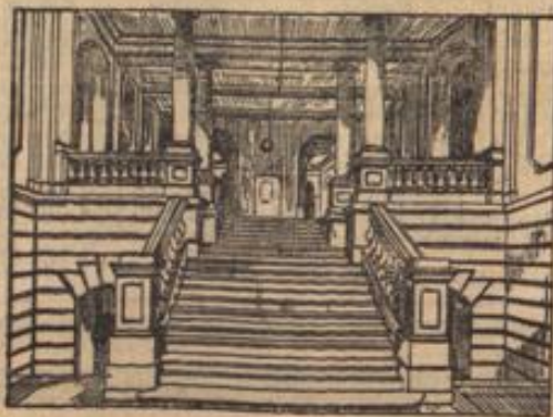
Aufgang zu den Lagerräumen
