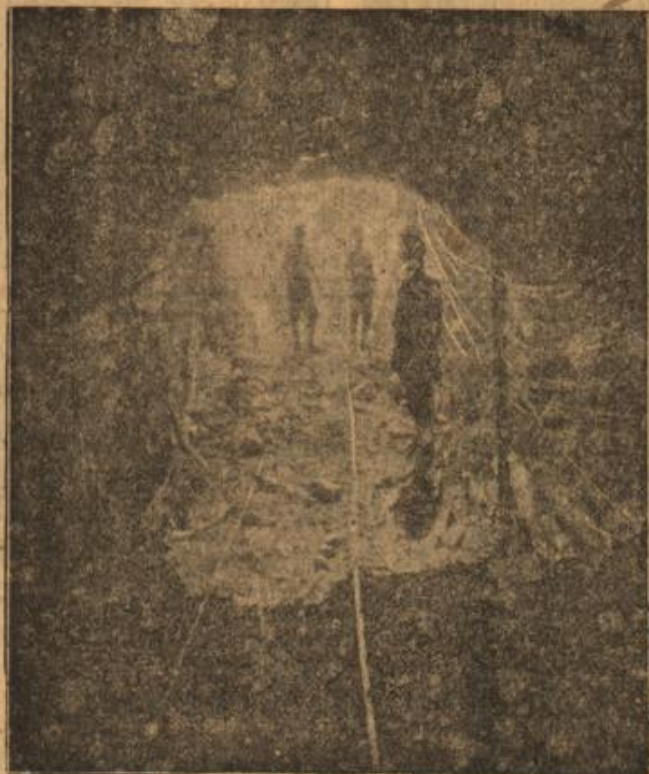
Eingang zur Kaverne eines höheren Kommandos am Monzo. Die Telefonbrüste rechts und links vom Eingang verbinden das Kommando mit den eingeklinkten Abschnitten der Front.
