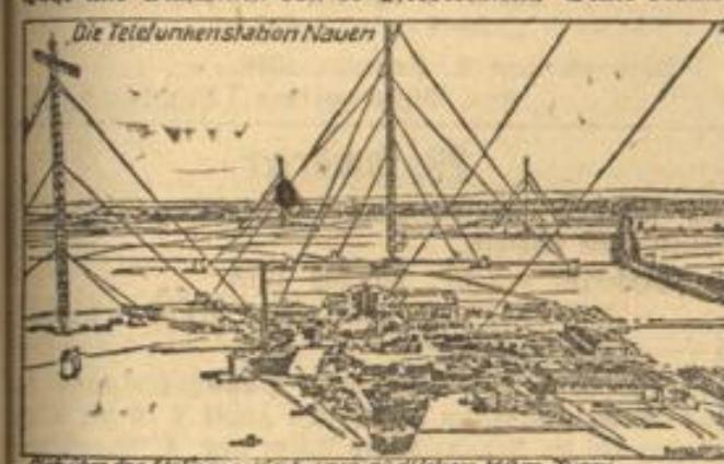
die Station über 1000 Pferdekraften zur Erzeugung elektrischer Wellen und verfügt über zwei Türme von je etwa 200 Meter Höhe (nur etwa 40 Meter niedriger als der Eiffelturm) und über sieben Türme von 120 bis 150 Meter Höhe. Ein ganzes Dach von Drähten verbindet die einzelnen Türme miteinander. 1000 Morgen Gelände nehmen
