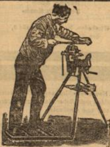
Reparaturen u. dgl. ausgeführt.
