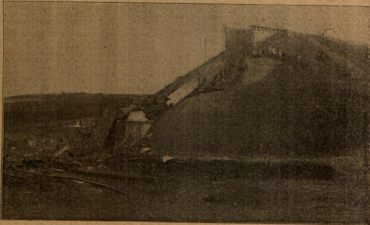
Ein von den Russen bei Landrowo gesprengter Eisenbahnviadukt, 21 Meter hoch auf der Strecke nach Danaburg, der durch unsere Eisenbahner innerhalb 8 Tagen wiederhergestellt wurde.
