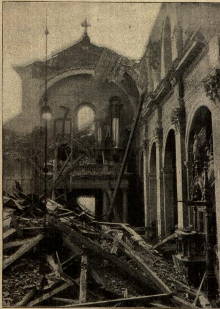
Das Innere der zerstörten Kirche von Gorlice.
