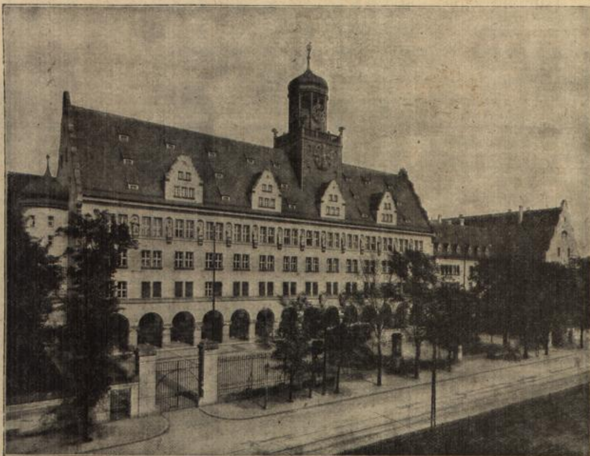
Das neue Zentraljustizgebäude in Nürnberg. (Mit Text.)
