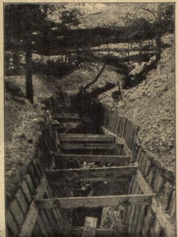
Bau eines 15 Meter tiefen Kanals an der Westfront. (Mit Text.)
