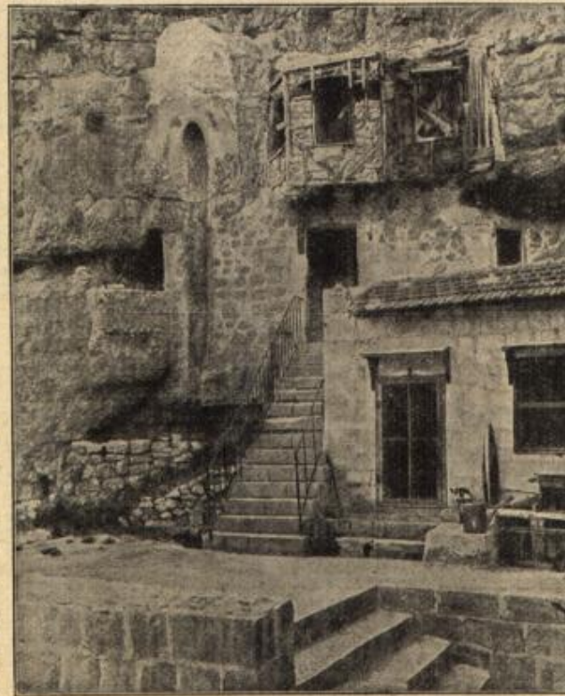
In die Felswände von Mar Zaba eingebaute Mönchswohnungen.
