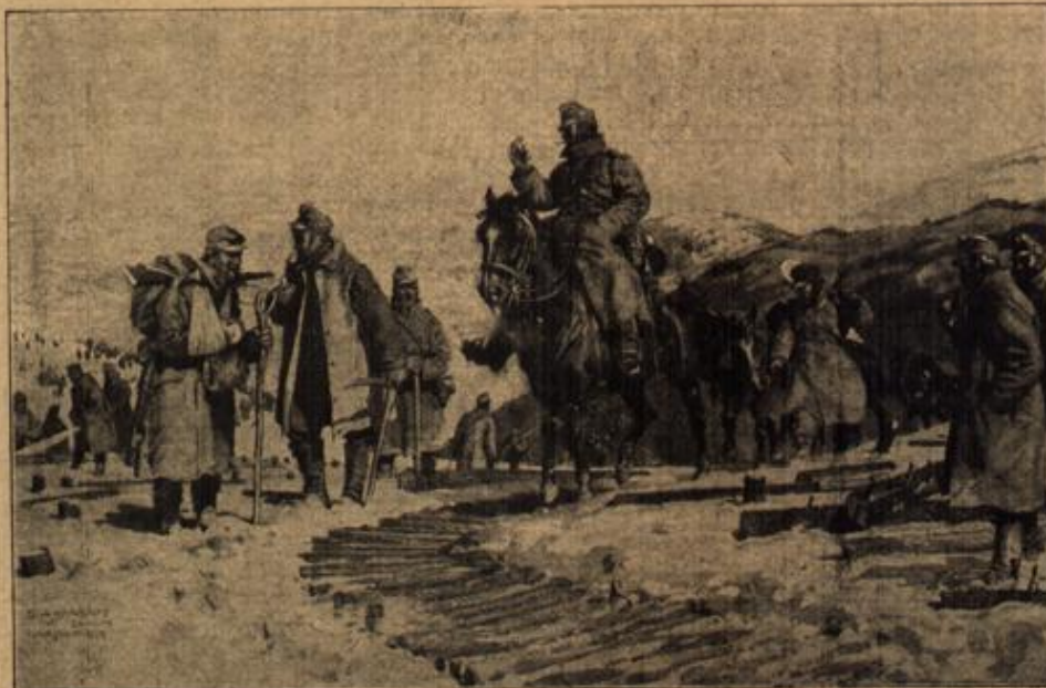
Herstellung von Anäppeldämmen durch österreichisch-ungarische Arbeitsabteilungen.
