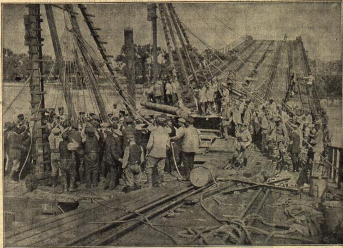
Deutsche Pioniere bei der Instandsetzung der von den Russen gesprengten Weichselbrücken in Warschau. (Mit Text.)
