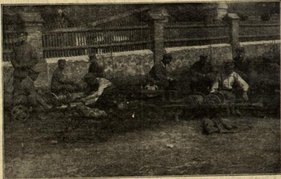
Vom östlichen Kriegsschauplatz: Mannschaften eines Fernsprechzuges beim Reparieren von Kabeln und Leitungsdrähten. (Phot.: Photothek, Berlin.)
