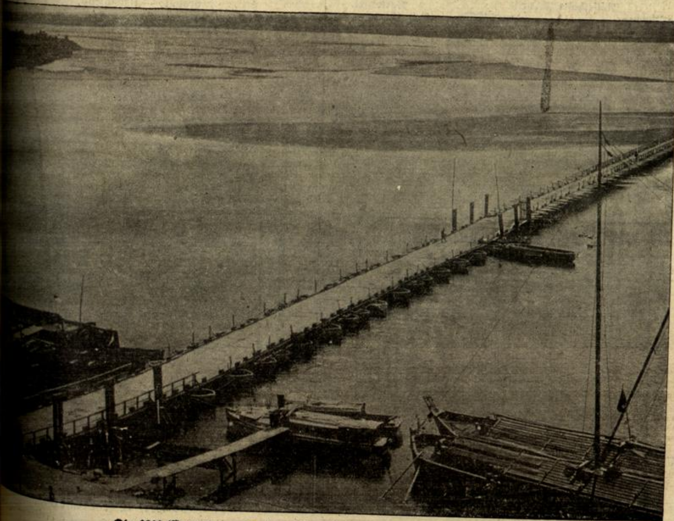
Die 1200 Meter lange Pontonbrücke bei Wyszogrod an der Weichsel, die in drei Tagen erbaut wurde.
