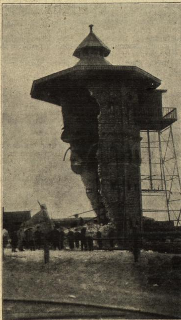
Vom östlichen Kriegsschauplatz: Ein von den Russen zerstörter Wasserturm an der Bahn nach Warschau. (Phot.: Leipz. Presse-Büro.)
