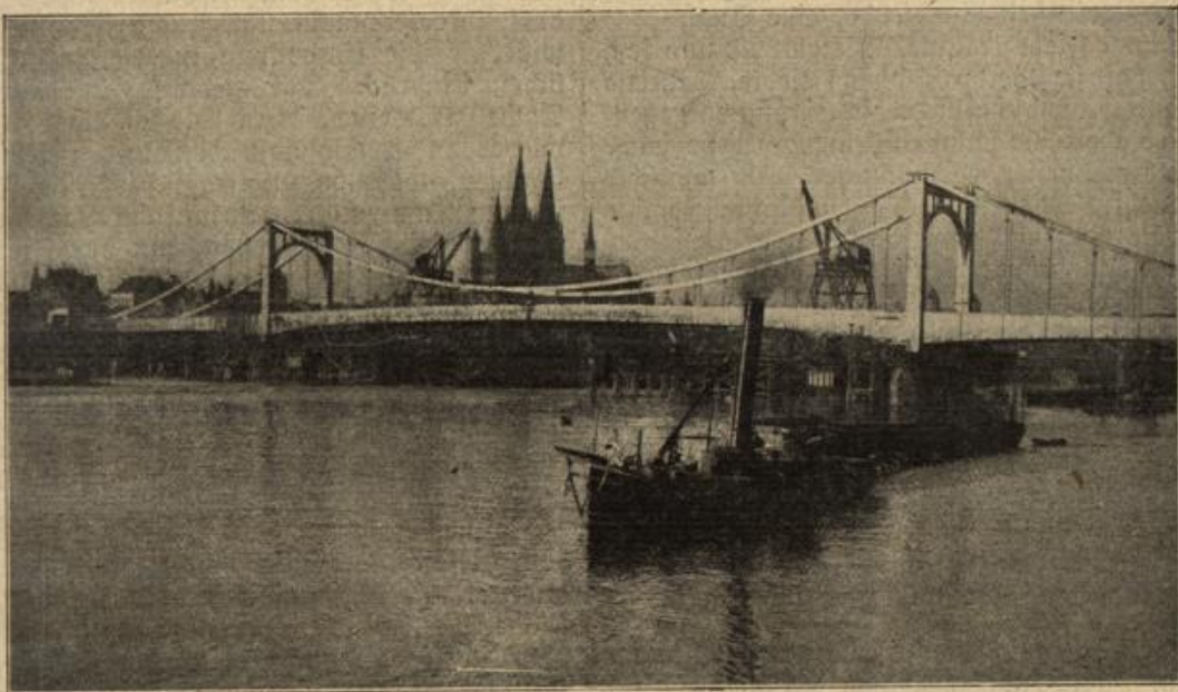
Die neue Rheinbrücke in Cöln, ausgeführt von der Maschinenfabrik Augsburg-Nürnberg, Werk Gustavsburg.
