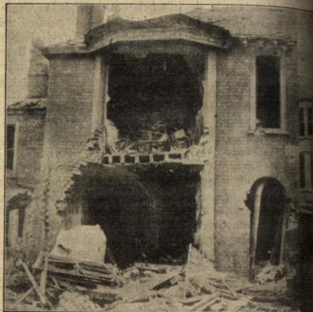
Vom Zeppelinangriff auf die Ostküste Englands: Von Bomben beschädigte Häuser auf St. Peters-Platz in Yarmouth. (Phot.: Photothek, Berlin.)
