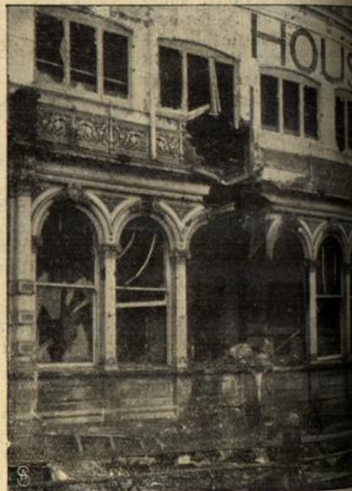
Die zerstörte Fassade eines Hotels in Scarborough.
