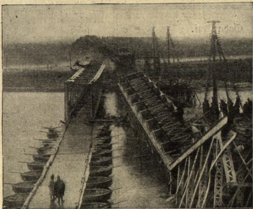
Die gesprengte große Warthebrücke in Esradz in Polen.
