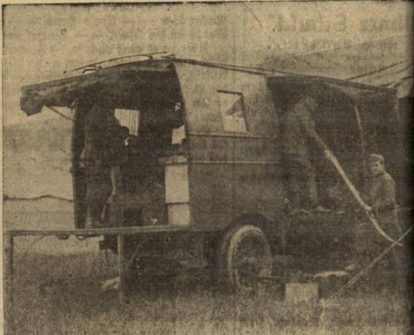
Eine auf Kraftwagen montierte englische Flugschiff-Reparaturwerkstätte im
