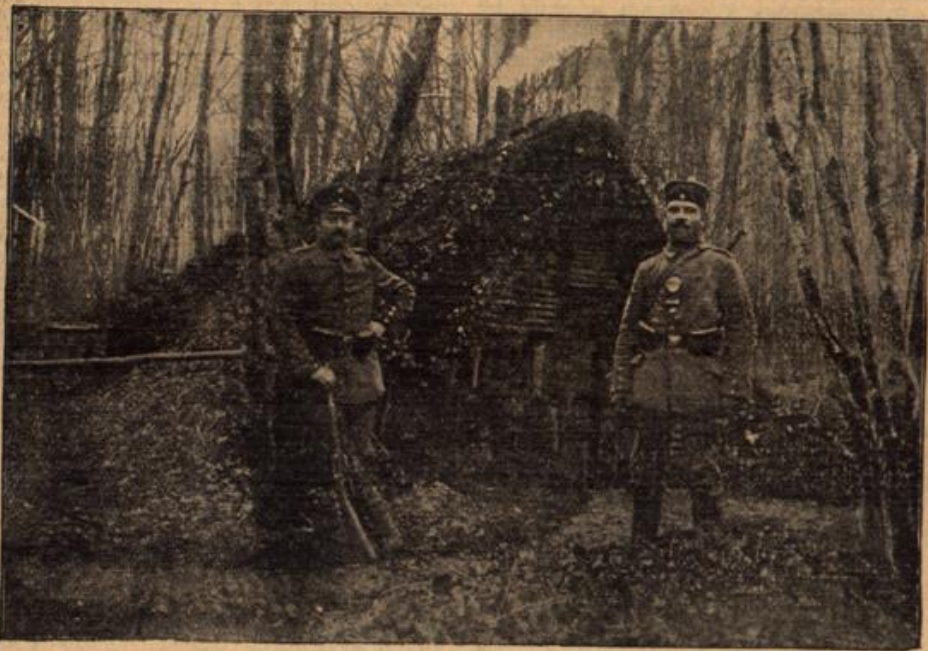
Beim Bau eines Unterstandes im Argonner Wald.
