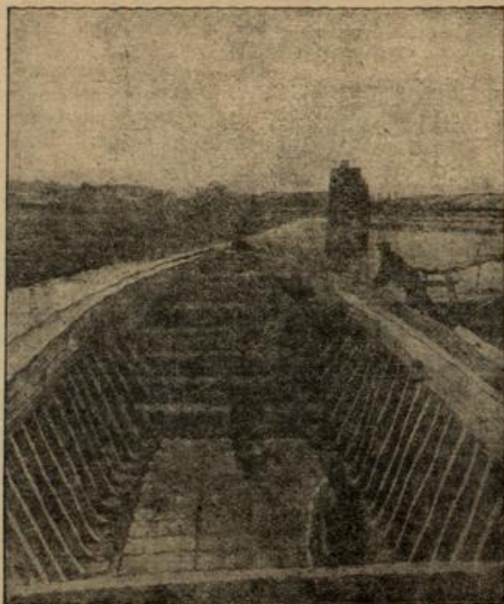
Offene Schute aus Eisenbeton von circa 87 Tonnen Tragfähigkeit. (Mit Text.)
