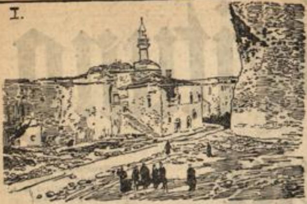
Granatwirkung an einem Nebengebäude innerhalb der Festung Kaleh Sultani
