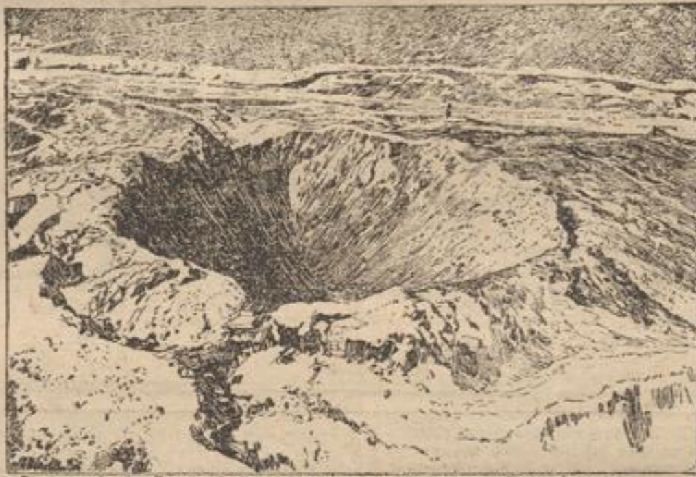
Der durch die Explosion einer Mine entstandene Erdkrater. (Im Vordergrund die zerstörten und verschütteten Schützengräben u. Unterstände)
