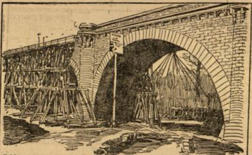
Eine von den Franzosen gesprengte Eisenbahnbrücke über die Aisne, von deutschen Eisenbahntruppen wieder hergestellt.
