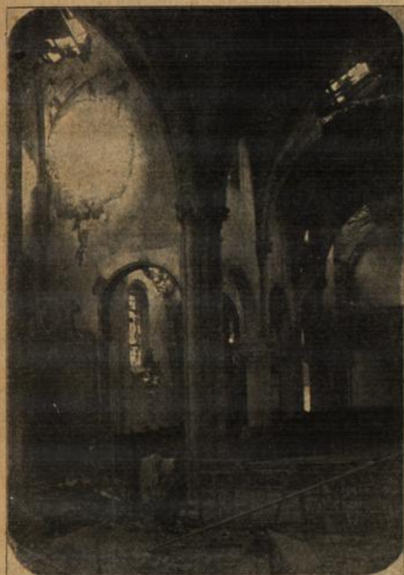
Souppont. Das Innere der zerstörten Kirche.
