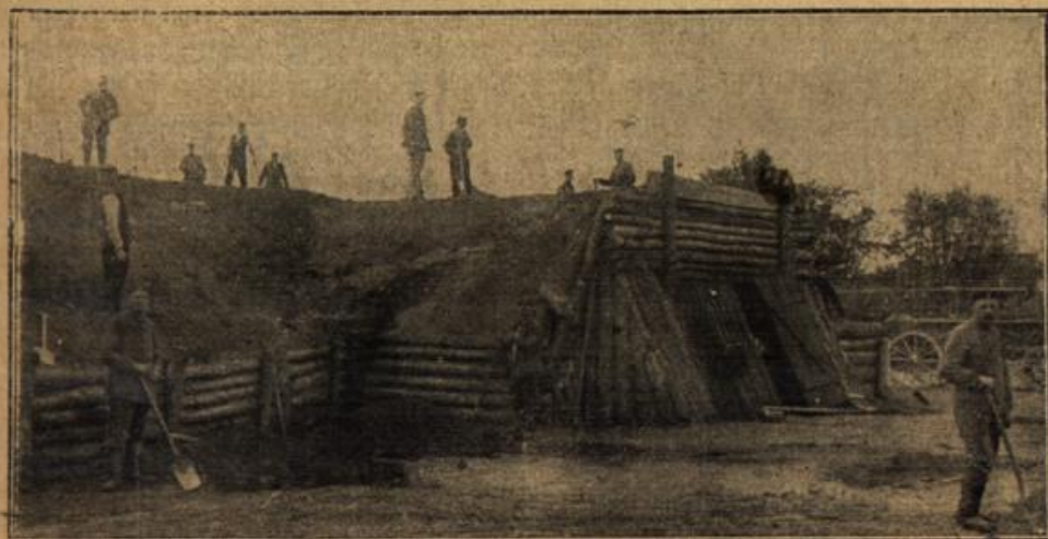
Bau eines Unterstandes für Munition.
