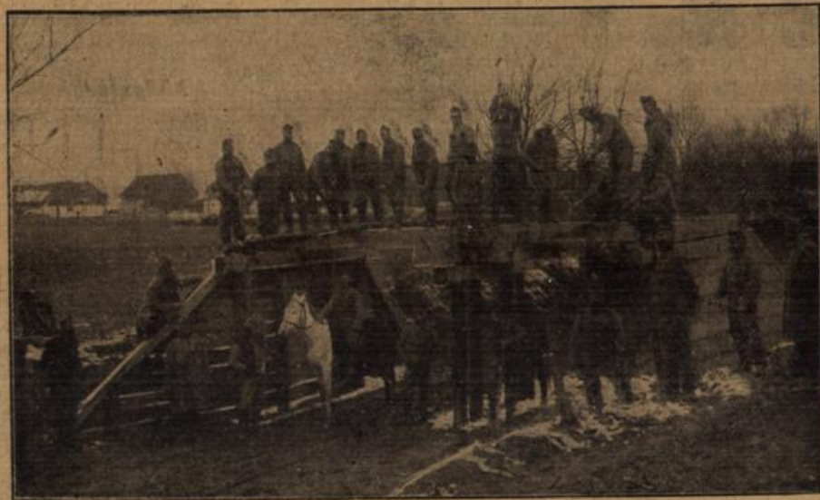
Österreichische Pioniere beim Bau einer Brücke für die Feldbahn.
