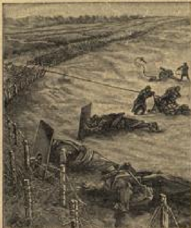
Frankenische Pioniere arbeiten am den ostlichen Schienenstrahlen, um, gedeckt durch Stahlhülle, die Drahtseile zu durchschneiden. (Abbildung aus der Gratis-Belagerung: „Im Zeichen des Krieges.“)
