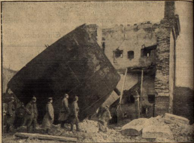
Gesprengter Wasserturm in Nowo- Radomsk.
