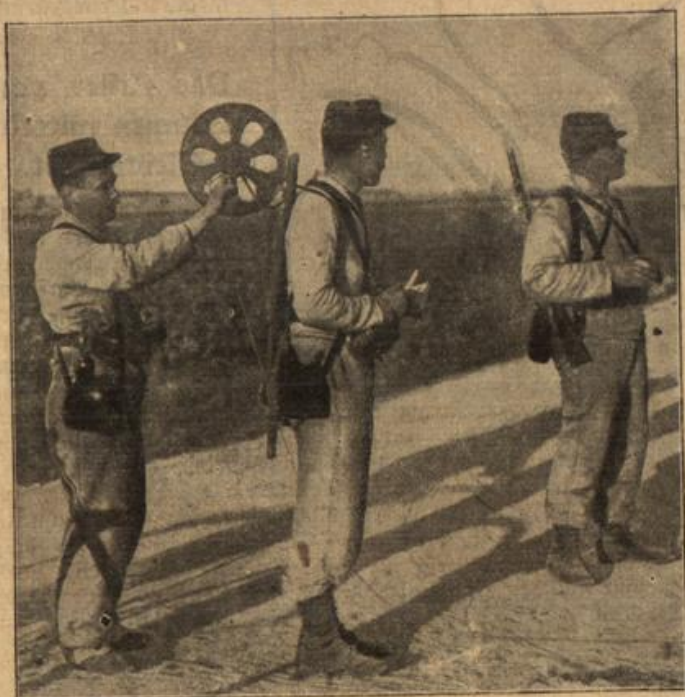
Telegraphendienst an der französischen Front. Eine Telegraphen-Abteilung repariert zerrissene Drähte. Die Spule, die der Soldat auf dem Rücken trägt, dient zum Auf- und Abspulen des Drahtes.
