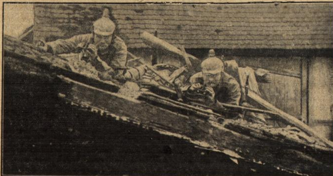
Eine Patrouille auf einem zerstörtem Dach.
