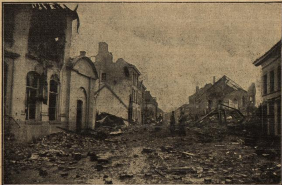
Zerschossene Straße in Dixmuiden.
