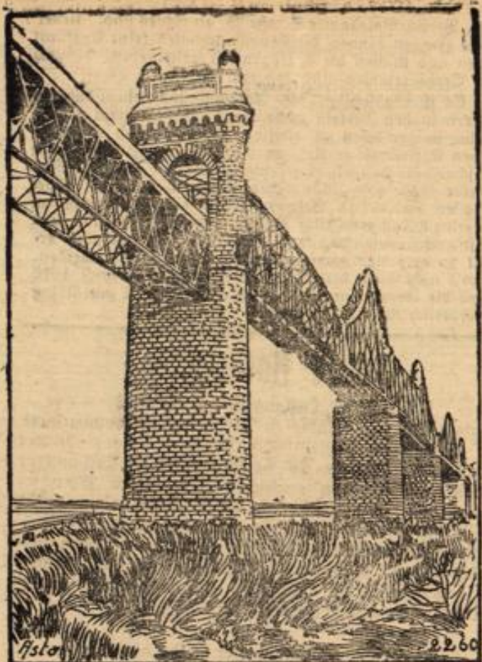
Donaubrücke bei Cernavoda.
